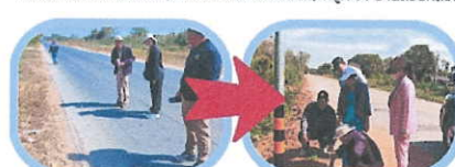
โครงการก่อสร้างติดตั้งเสาไฟส่องสว่างสาธารณะ บริเวณเขื่อน ถึงหนองหมู หมู่ที่ 15 บ้านหนองสาระบั้ง
