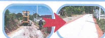
โครงการก่อสร้างถนนผิวจราจร คสล. บริเวณซอยตะพานพร้าว (นายเชิดศักดิ์ จำปาเดิม) หมู่ที่ 14 บ้านสวนกล้วย
