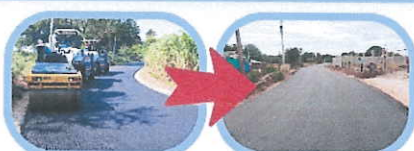
โครงการปรับปรุงถนนผิวจราจรลาดยางแอสฟัลต์ติกคอนกรีต สายหนองแก หมู่ที่ 5 ตำบลหนองกบ อำเภอบ้านโป่ง จังหวัดราชบุรี
