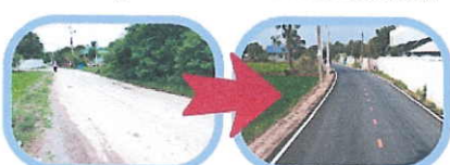
โครงการปรับปรุงถนนผิวจราจรลาดยางแอสฟัลต์ติกคอนกรีต บริเวณตำบลยางสามต้นถึงบ้าน นางสาว สอนแพ ม.7
