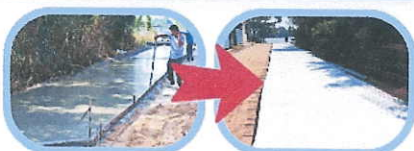
โครงการก่อสร้างถนนผิวจราจรคอนกรีตเสริมเหล็ก บริเวณซอยข้างบ้านเลขที่ 222 หมู่ที่ 4 ตำบลบึงกระเจ็ด
